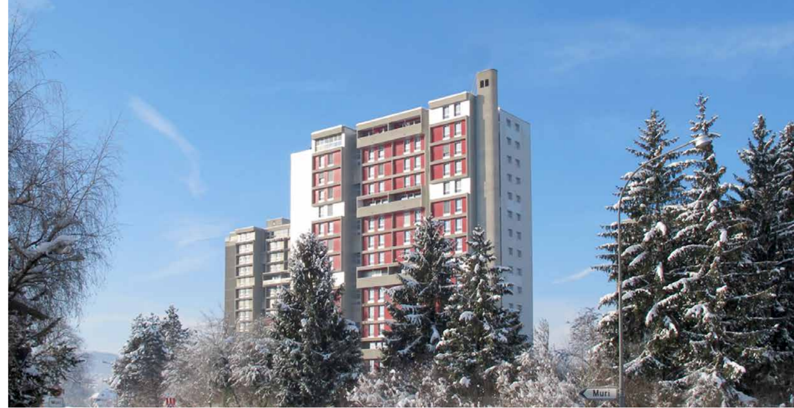
Risanamento di una casa plurimfamiliare a Muri vicino a Berna
