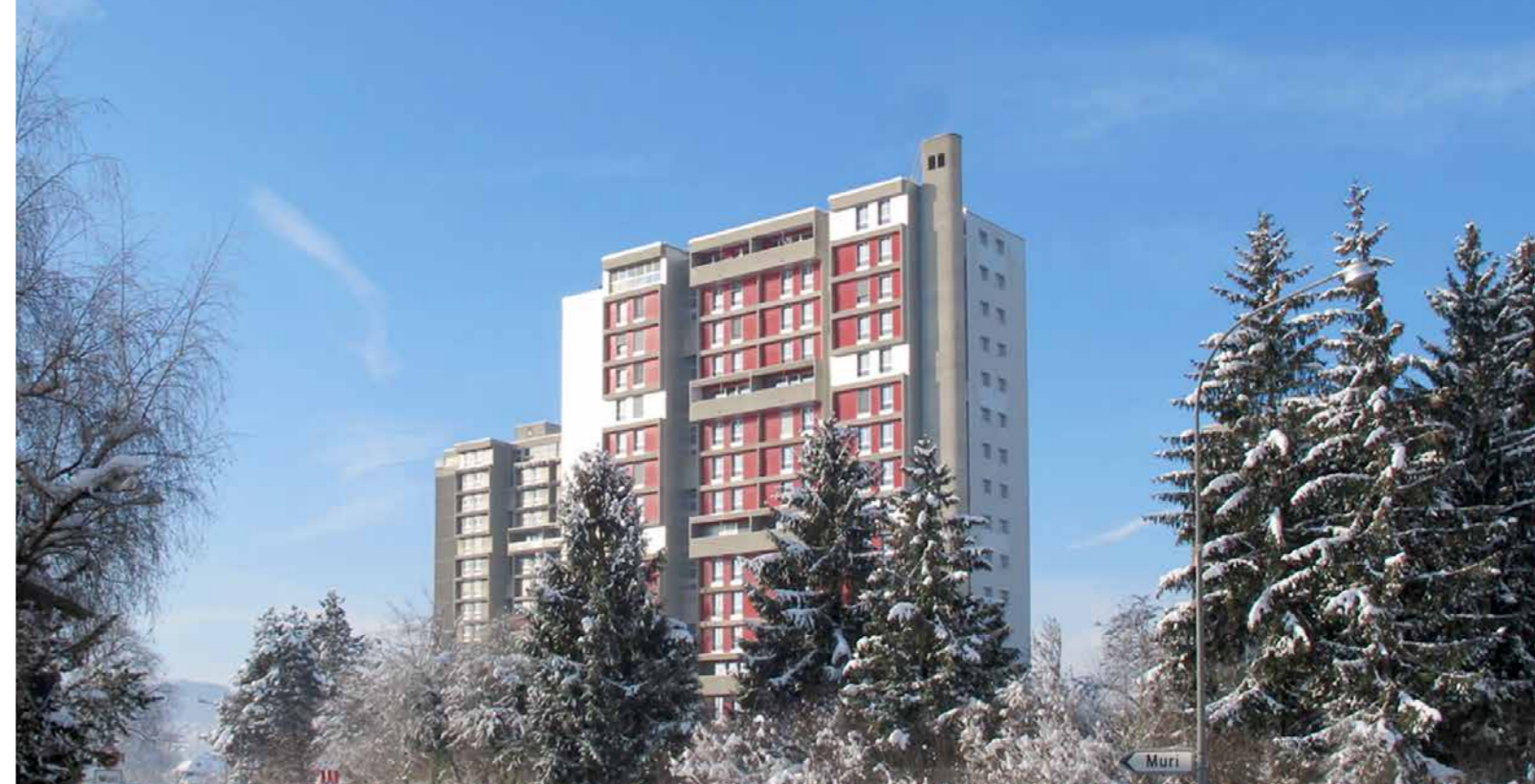
Rénovation d'un immeuble à Muri près de Berne
